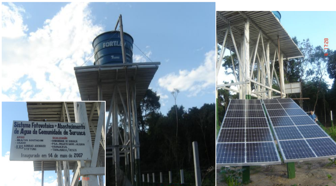
Fotografia 43 – O sistema de abastecimento de água. A água é bombeada para as casas por meio de um gerador alimentado por energia solar Fonte: Heidtmann Neto (2007)
