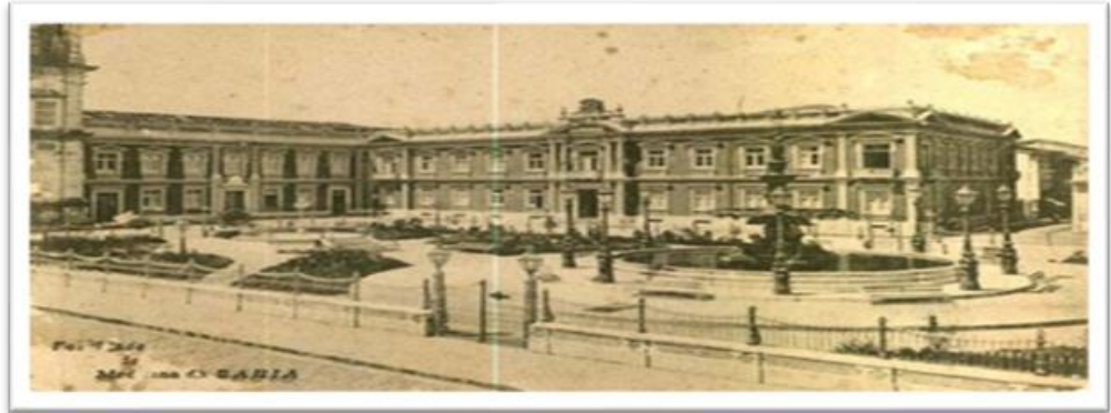
Figura 14 - Edifício da antiga Faculdade de Medicina da Bahia - atual UFBA.
