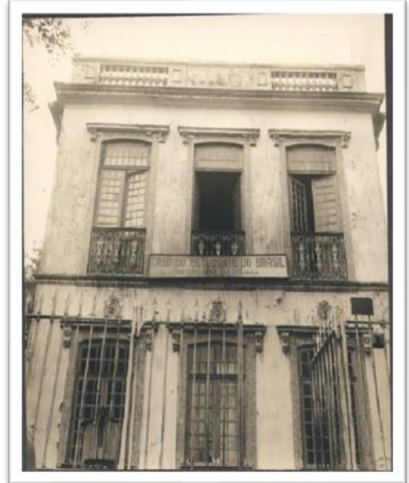
Figura 12 - Prédio da Residência Feminina da Casa do Estudante do Brasil.
