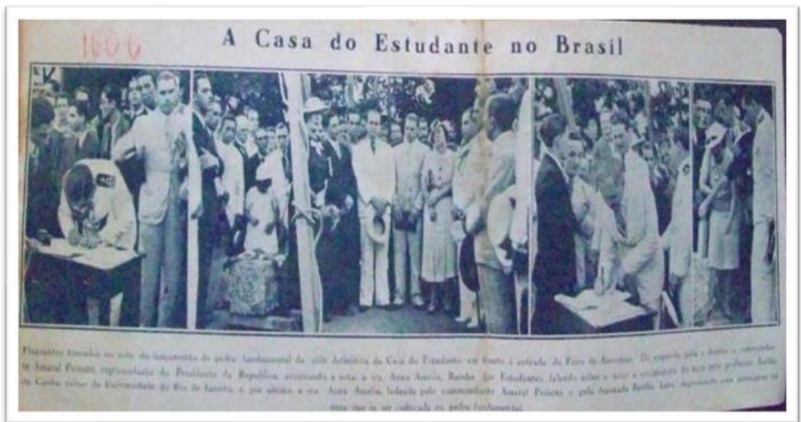
Figura 9 - Lançamento da Pedra Fundamental da Casa do Estudante do Brasil.
