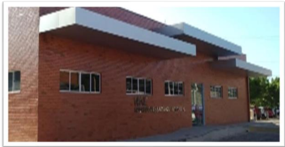
Figura 22 - Prédio da PRAE/UFDPAr
