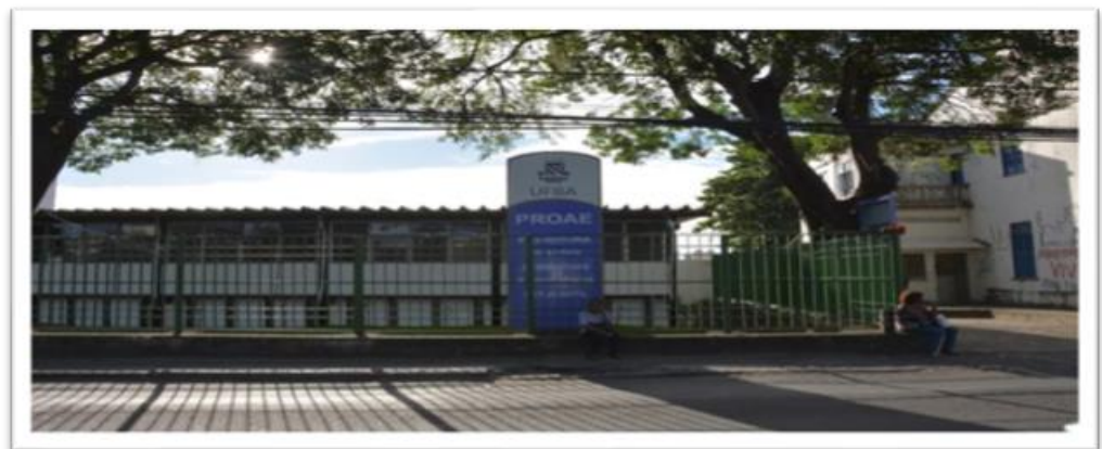
Figura 16 - Prédio da PROAE/UFBA
