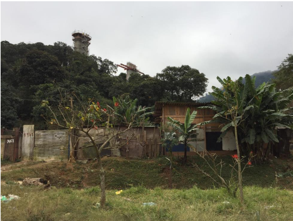
Figura 24 – Em primeiro plano, trecho final do Parque do Canivete. Em segundo plano, construções irregulares em APP. Ao fundo, pilares em construção do trecho Norte do Rodoanel, em jul. 2017
