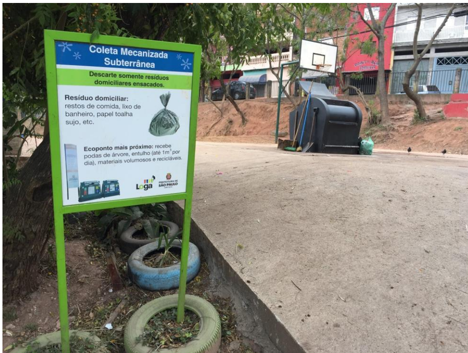
Figura 31 – Em primeiro plano, sinalização informativa acerca da lixeira de depósito subterrâneo que se observa em segundo plano, em jul. 2017
