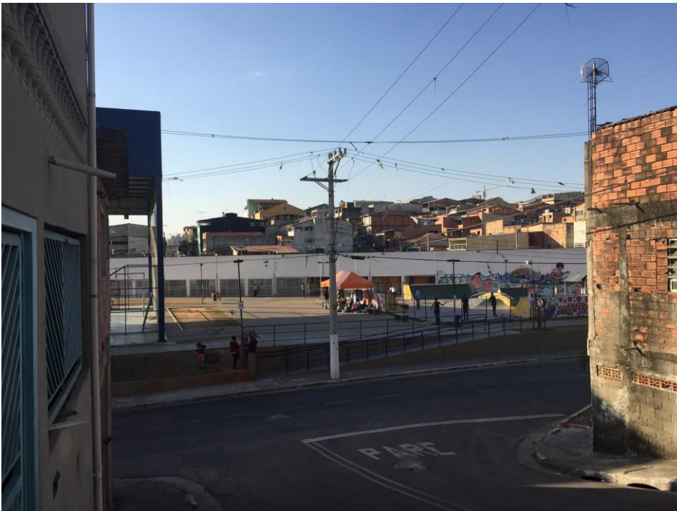
Figura 41 – Ausência de muros ou gradis ao redor do CEU das Artes Camila, ago. 2017
