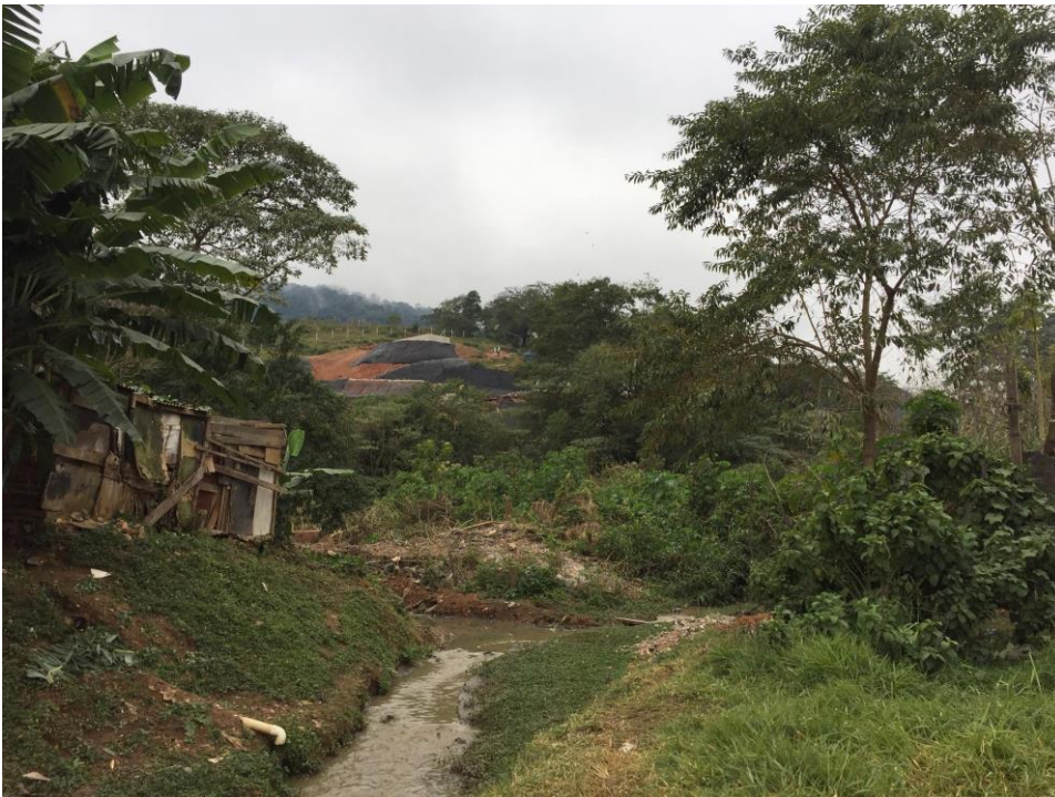
Figura 22 – Ao norte do Parque do Canivete, movimento de terra das obras do Rodoanel, em jul. 2017
