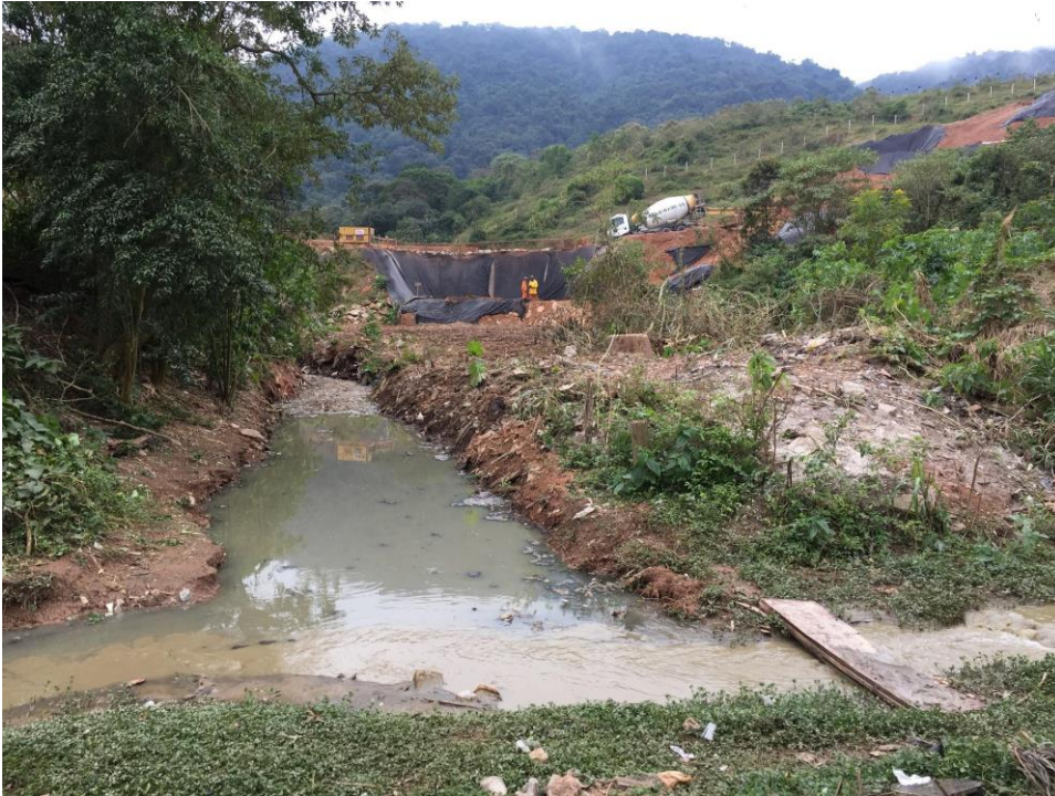
Figura 23 – Encontro de dois córregos com muitos sedimentos no trecho final do Parque Linear do Canivete. Ao fundo, movimento de terra das obras do Rodoanel, em jul. 2017
