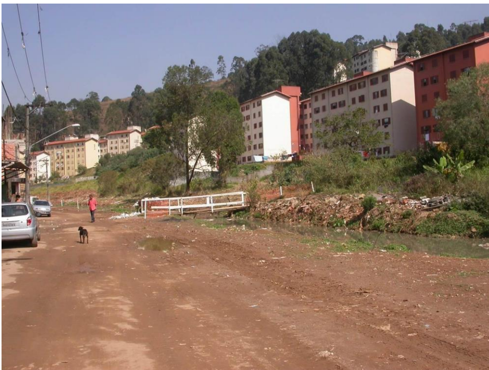
Figura 8 – Av. Hugo Ítalo Merigo após a remoção, durante as obras
