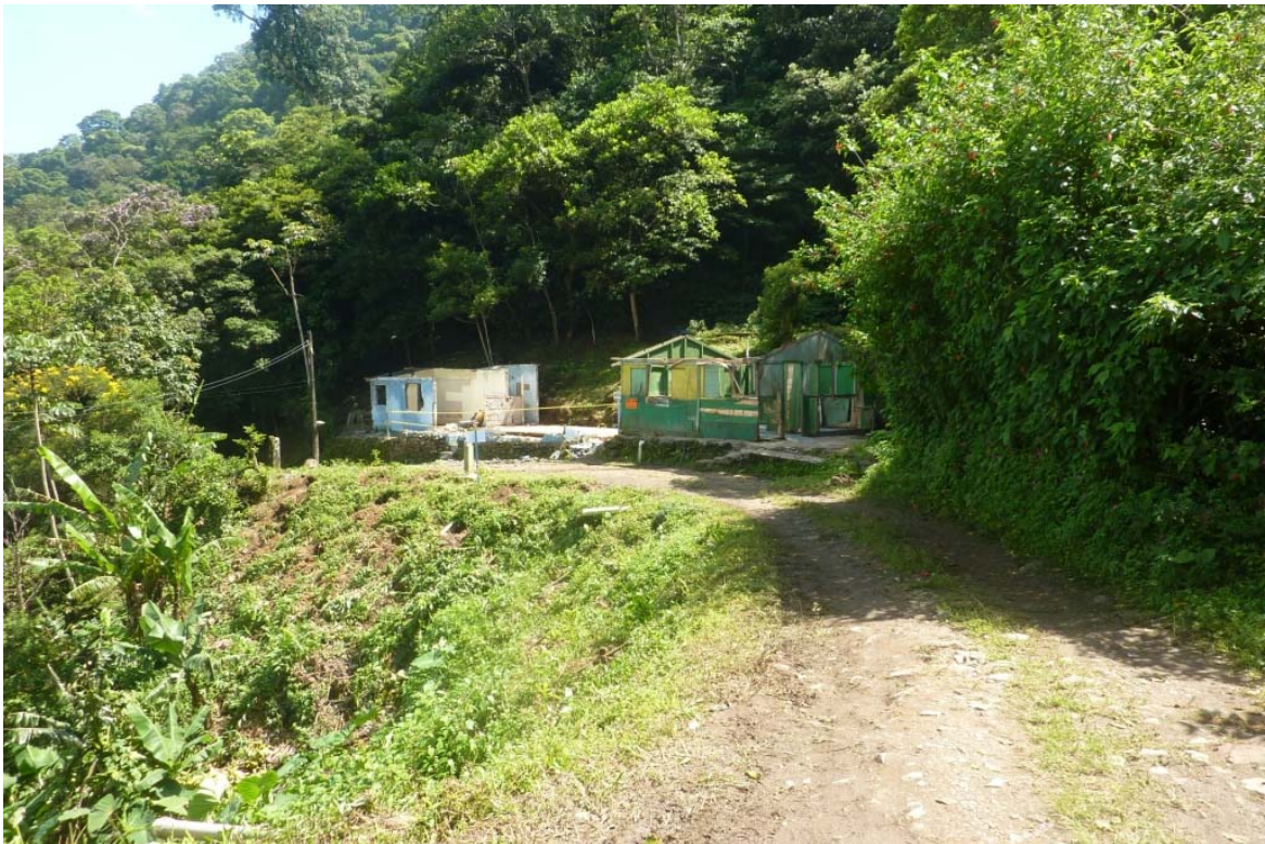
Foto 8 – Casas em fase de demolição na Cota 400 Fonte – Roberta Buendia Sabbagh, 2009.
