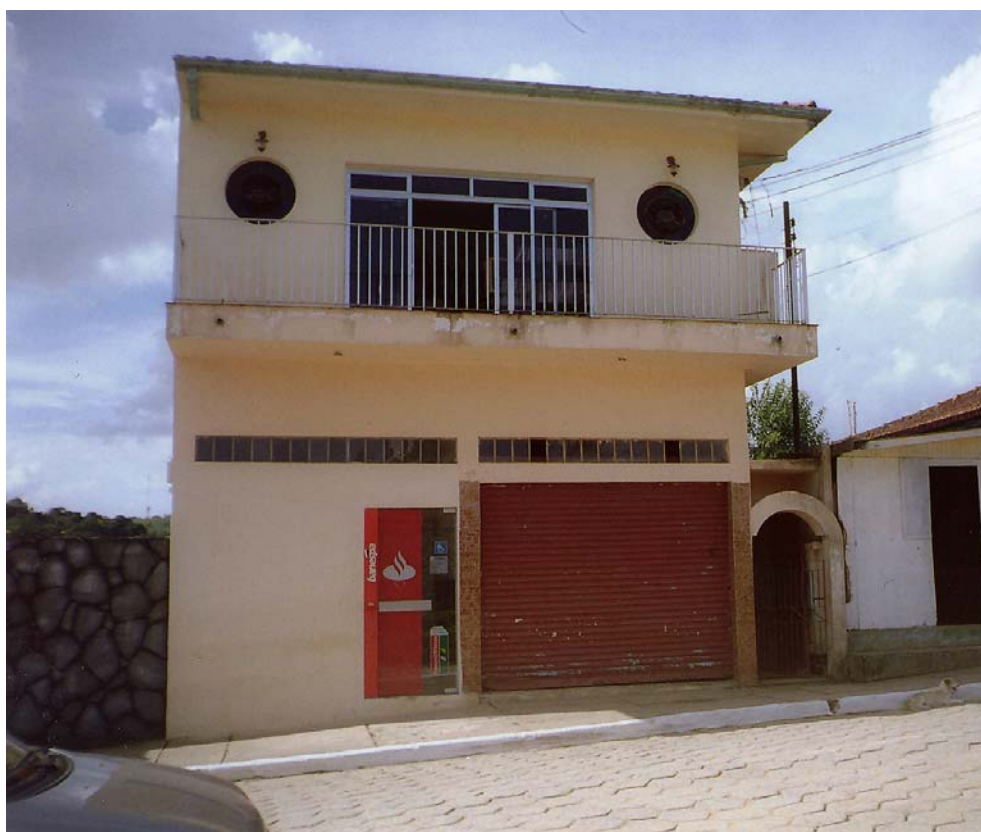
Fachada da biblioteca pública municipal de Barra do Chapéu, SP, piso superior
