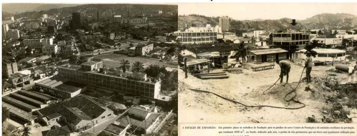
Fotografia 13. Foto da reforma nas edificações do IVB, com construtores em destaque, sem data.
