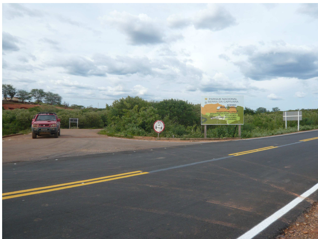
Figura 27) Sinalização – Acesso Pedra Furada – Acervo FUMDHAM
