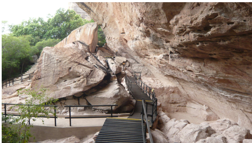
Figura 21) Infraestrutura Sítio do Meio – Acervo FUMDHAM
